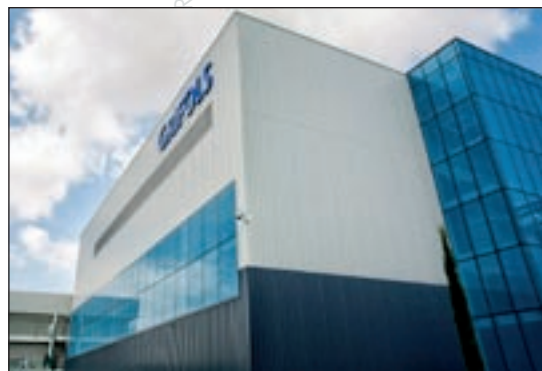
Una de les plantes del complex de Grifols a Parets
