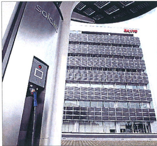
Paneles solares en el centro de Sanyo en Kasai
